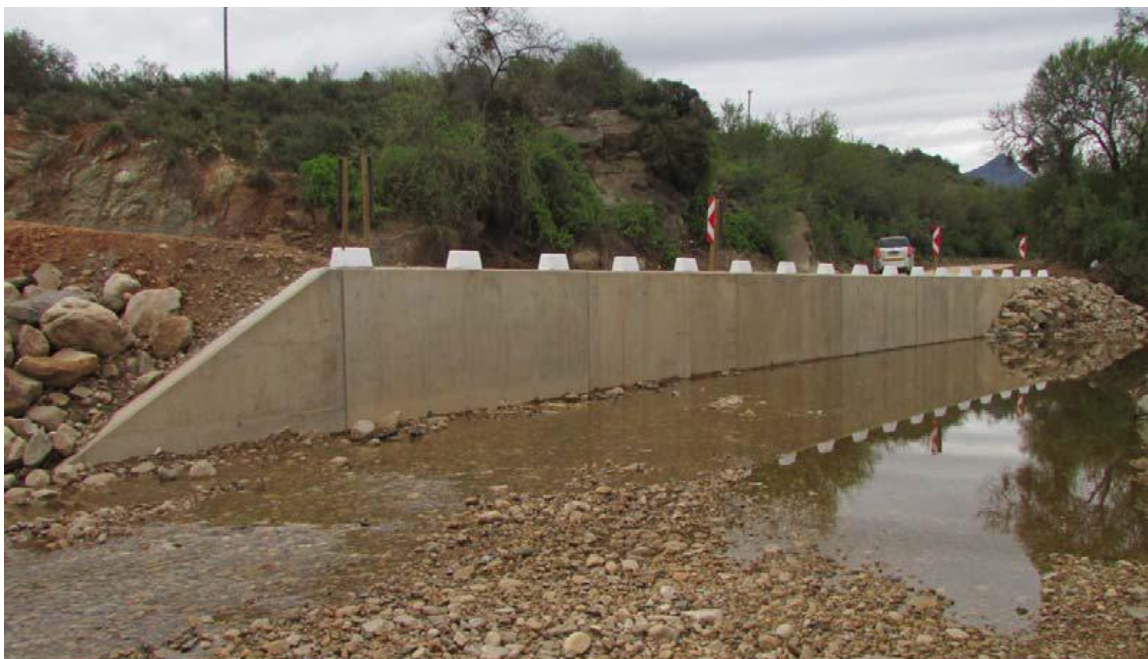
Retaining Wall (Opzoek – C960.1)
